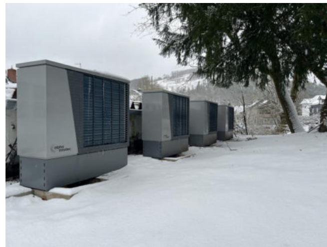
Wärmepumpenkaskade 36 kW
