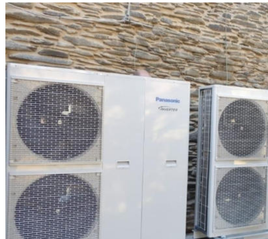
Wärmepumpenkaskade 48 kW
